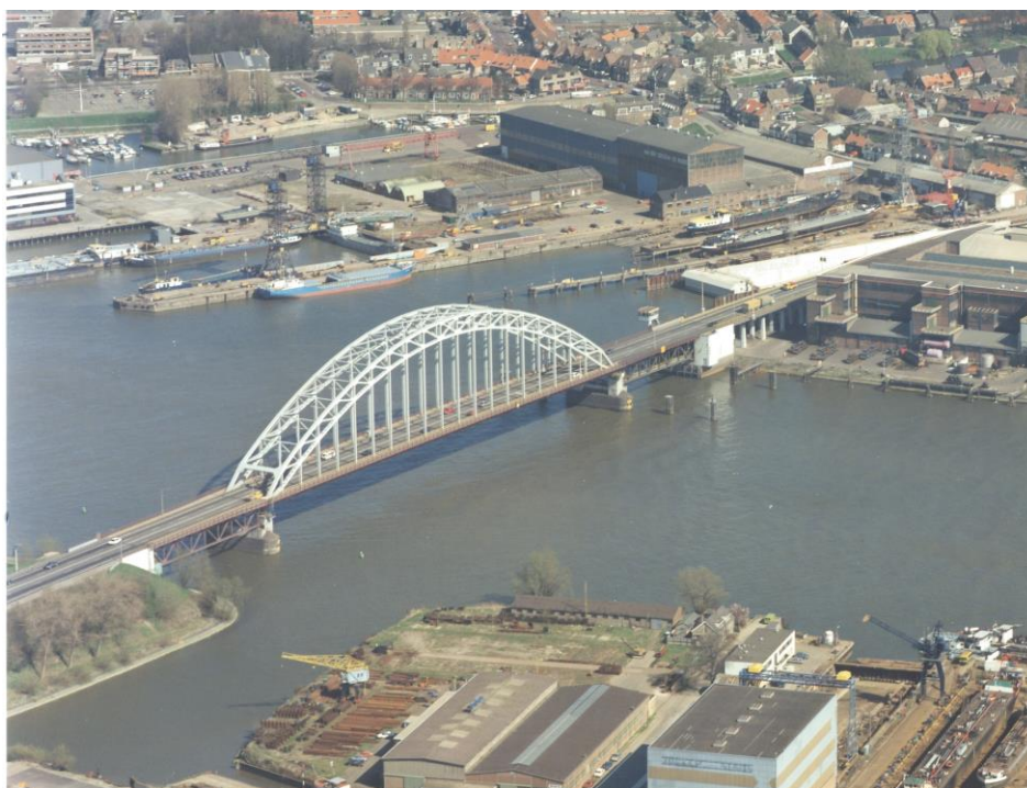
Foto 1 De Brug over de Noord in de N915.
