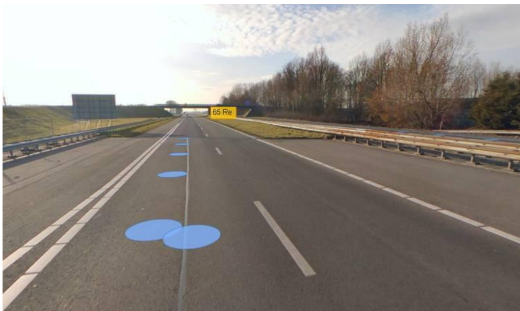
Figuur 3 Overkluizing van de leidingstraat die van Rotterdam naar Antwerpen voert in de A59. Dit kunstwerk (Oud-Land) dateert uit 1971.
