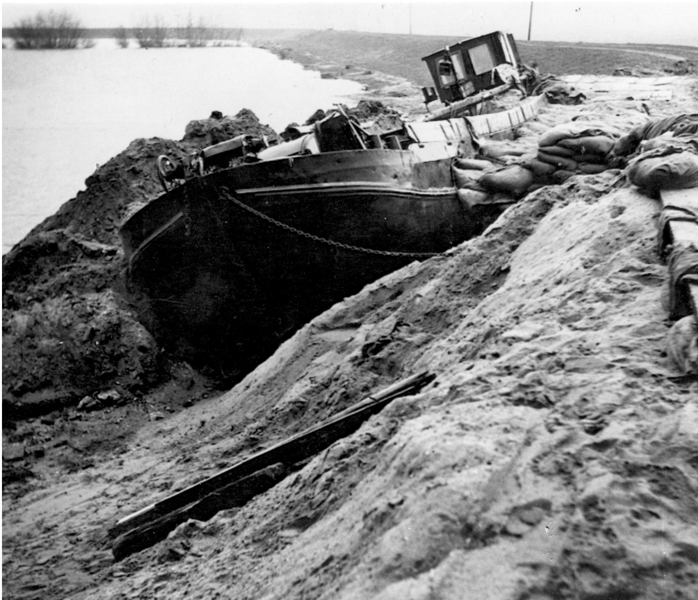
De Twee Gebroeders in de bres in de Schielandse Zeedijk.
