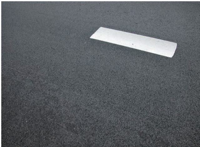
Detail tweelaags ZOAB vijf jaar na aanleg.
