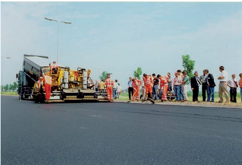
Demonstratie aanleg tweelaags ZOAB in 1999.
