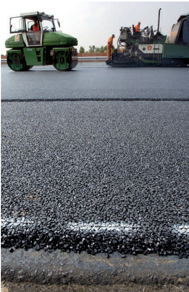
Verwerking van ZOAB en tweelaags ZOAB vindt plaats met gewoon materieel.
